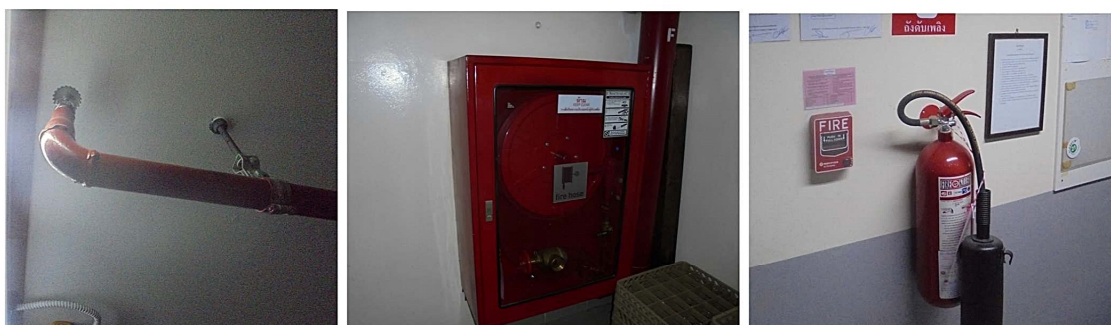
3-15 ระบบดับเพลิงอัตโนมัติชนิดหัวกระจายน้ำดับเพลิง และถังดับเพลิงเคมีแบบมือถือ Dry Chemical CO 2
