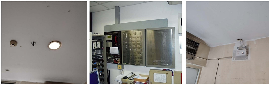
3-12 ระบบป้องกันอัคคีภัย ได้แก่ Conventional (Addressable System) , Single Action แบบ Pulldown และ Smoke Detector
