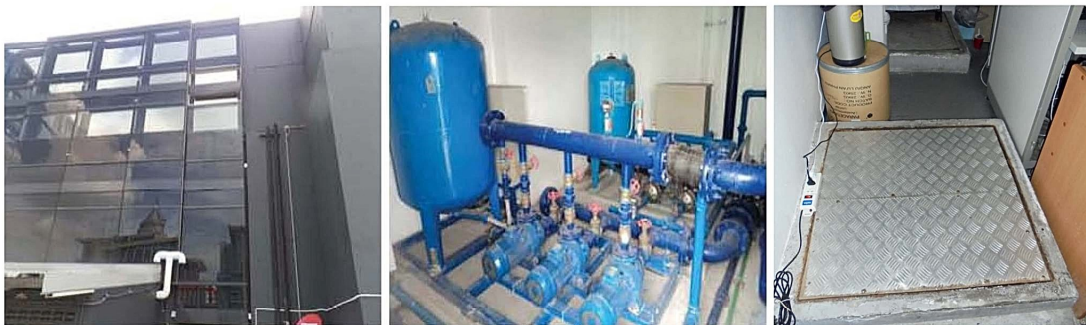
3-6 ถังสำรองน้ำใช้ชั้นดาดฟ้า และปั๊มสูบน้ำแรงดันสูง และถังสำรองน้ำใต้ดิน
