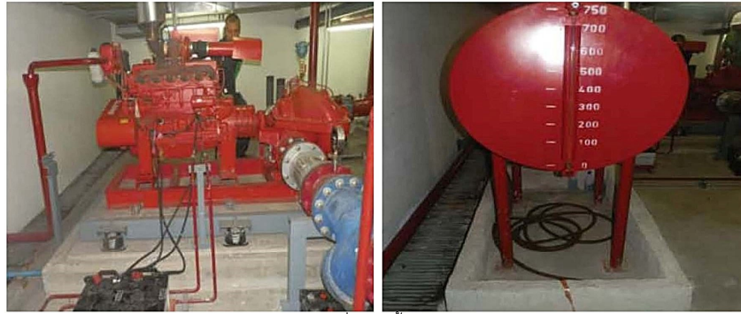
3-16 เครื่องสูบน้ำดับเพลิง
